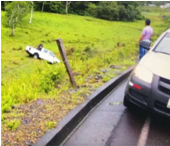
Vía sin peralte con una curva de extendida, vehículos pierden pista velocidad inapropiada
